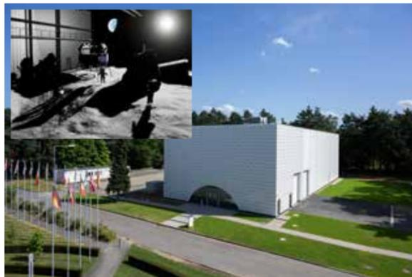
ESA-DLR LUNA模擬施設。内部の700 m<sup>2</sup>表土テストベッドエリアをレンダリングしたもの(挿入図)。(ESA/DLR-S. Asineta, F. Saling)
